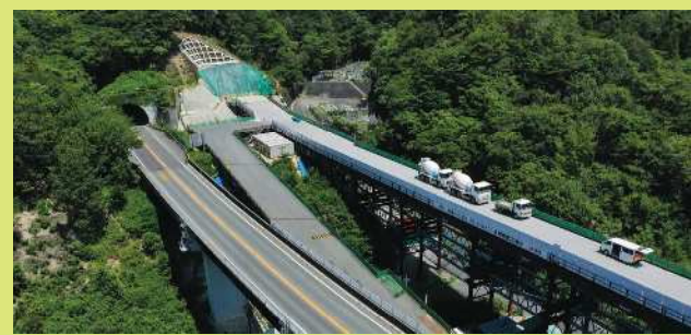
◀天応トンネル南側坑口
