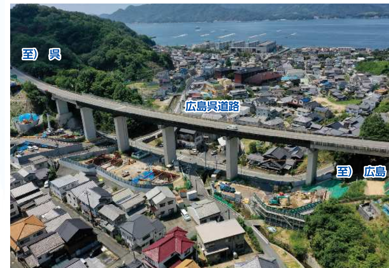
坂町 小屋浦地区
