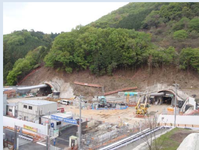
箕面トンネル西坑口 坑口部全景
