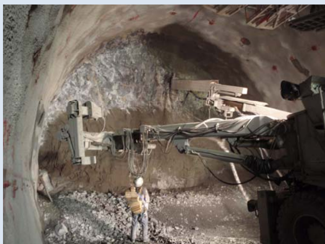
下り線施工状況(吹付けコンクリート施工状況)
