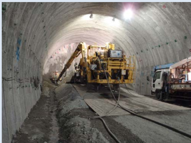
上り線施工状況(AGF削孔状況)
