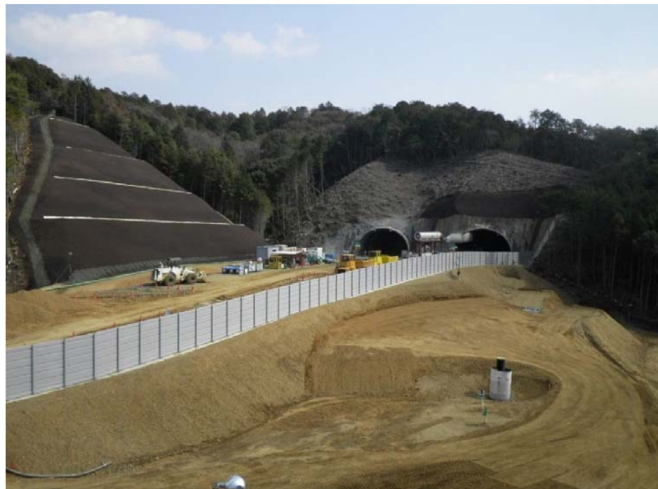
神峰山トンネル 終点側坑口ヤード 全景
