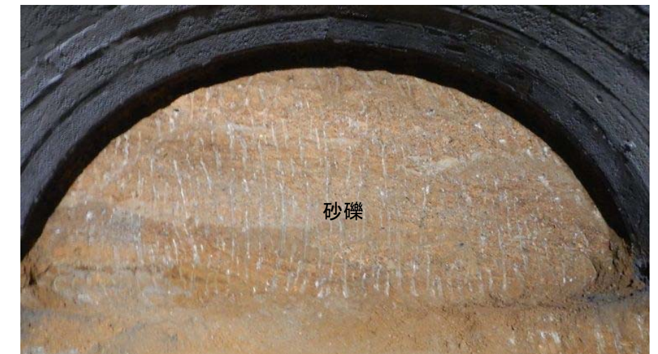
下り線 STA.112+95 切羽状況
