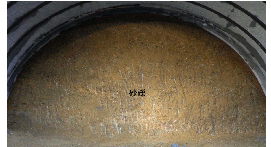
下り線 STA.114+35 切羽状況
