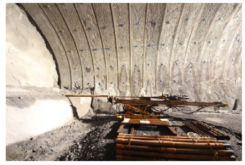
下り線側 長尺先進ボーリング施工状況 (L=120m)
