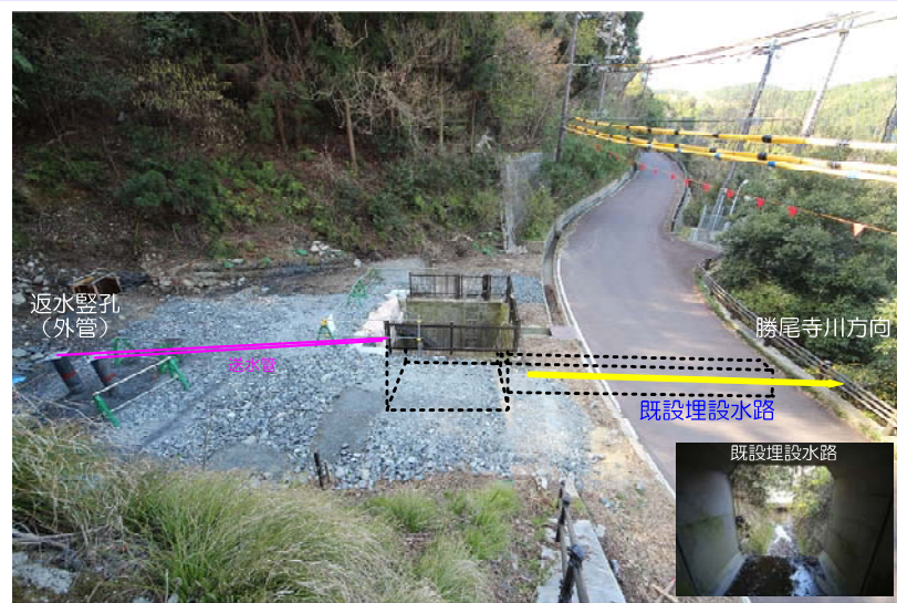
返水縦孔掘削完了 (外管のみ設置)
