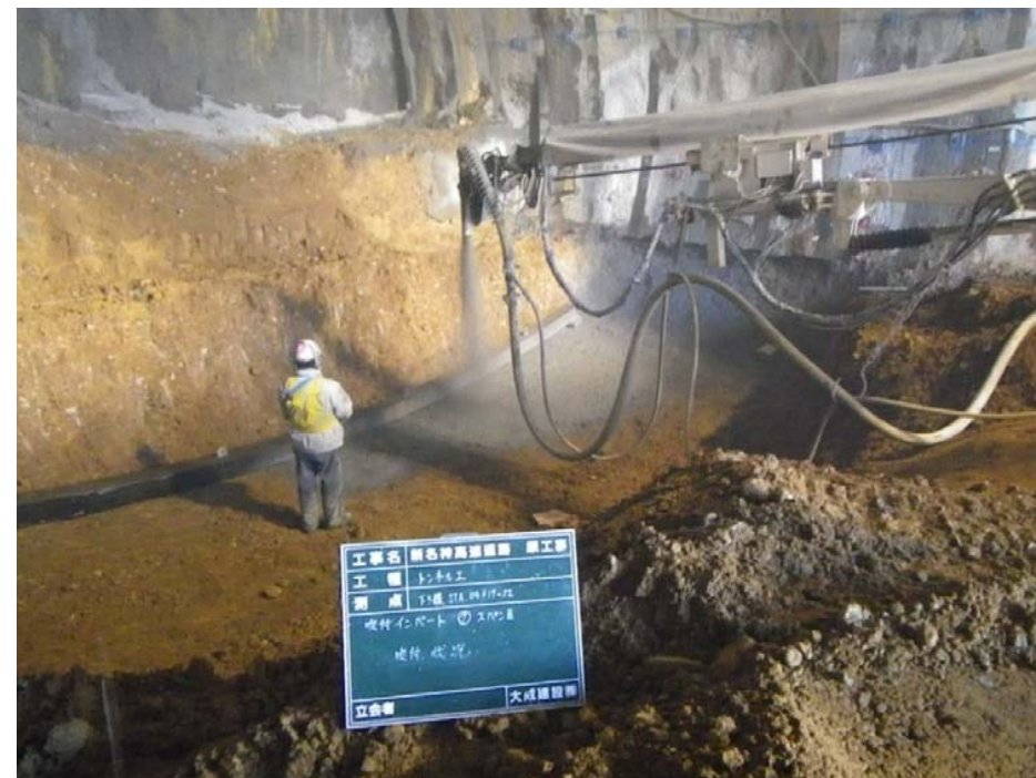
吹付けインバート 施工状況
