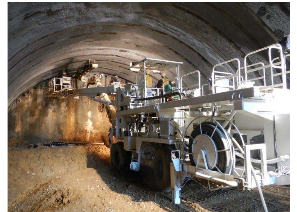
AGF施工状況
