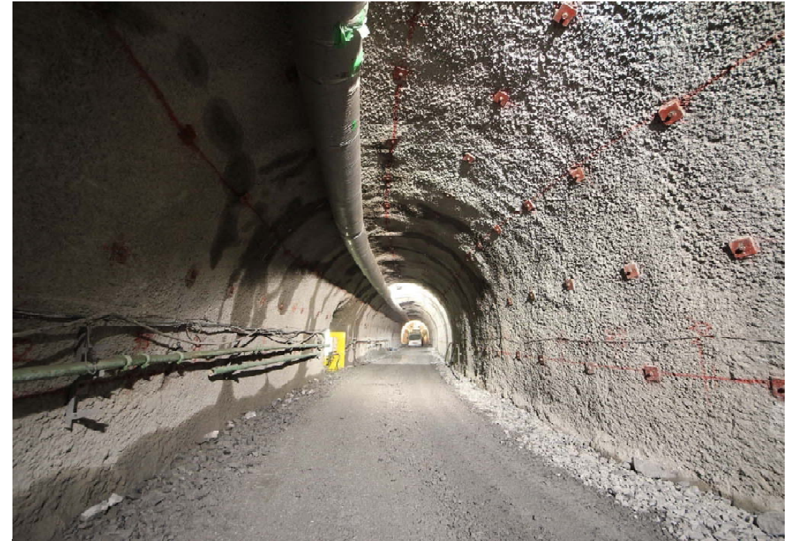
返水横坑の施工状況
