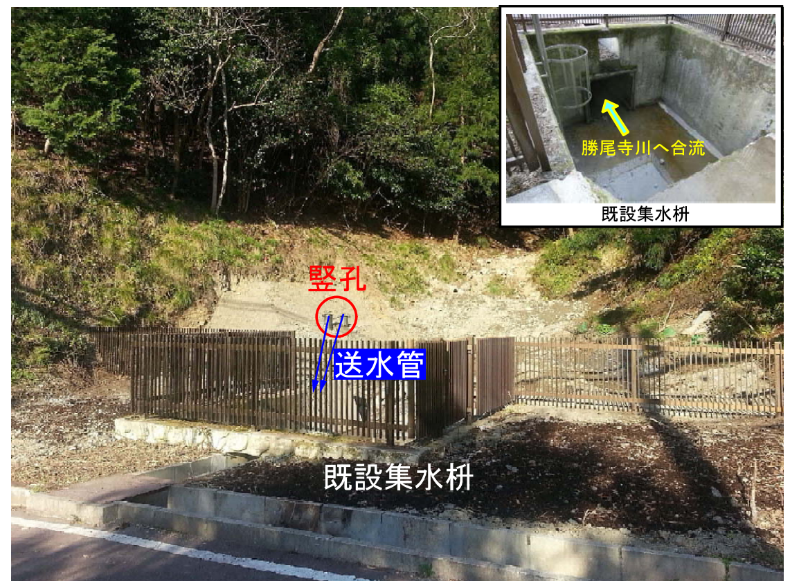
返水竖孔の設置状況
