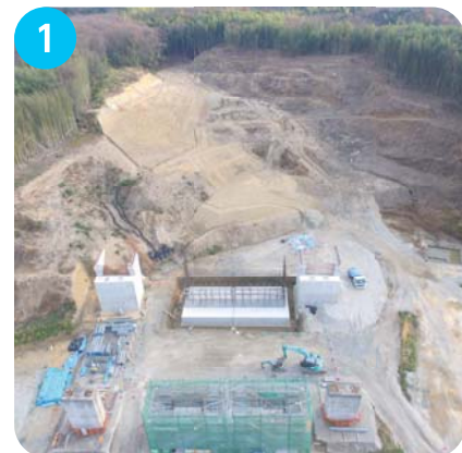
1 菅野地区状況 県道小部明石線、櫛谷川にかかる橋の橋台、橋脚を作っています。
