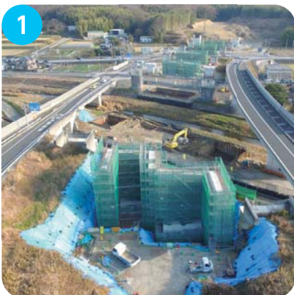
1 菅野地区状況 県道小部明石線、櫛谷川にかかる橋の橋台、橋脚を作っています。
