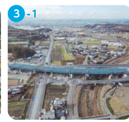
櫛谷IC付近 土工工事に着手しました。県道小部明石線から東に向かって地山の掘削を行っています。
