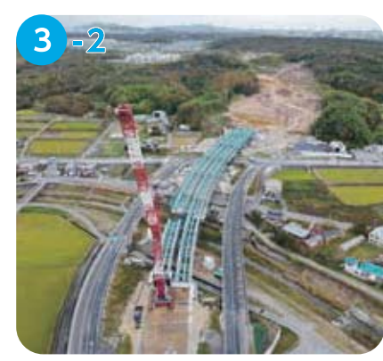
菅野交差点付近 専用部の橋梁工事を実施しています。R4.12月に櫛谷川上空の橋桁架設が完了しました。橋桁の架設には、750t吊クレーンを使用しました。これから橋面部分を施工していきます。
