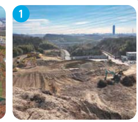
永井谷JCT付近 土工工事に着手しました。永井谷JCTから西に向かって地山の掘削を行っています。また、永井谷JCT部において橋台、橋脚の工事に着手していく予定です。
