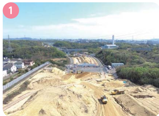
1 永井谷JCT付近 永井谷JCTにおいて、橋台、橋脚の基礎工事、山を掘削する土工工事を実施しています。
