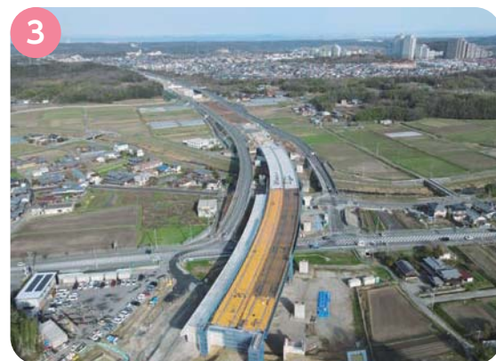
3 菅野交差点付近 県道明石木見線、櫛谷川を横架する橋梁工事を実施しています。
