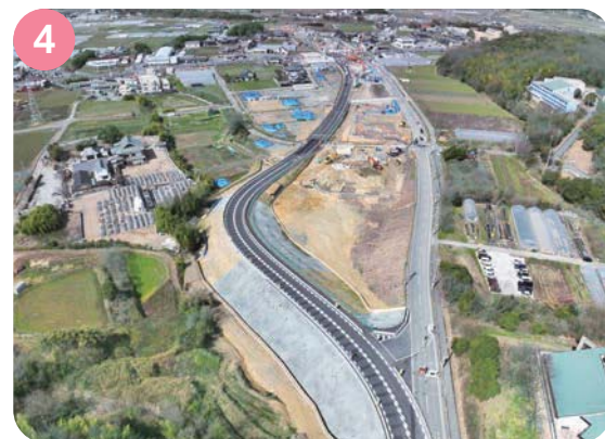
4 下村地区 下村地区から中村地区において、橋台、橋脚の基礎工事を実施しています。
