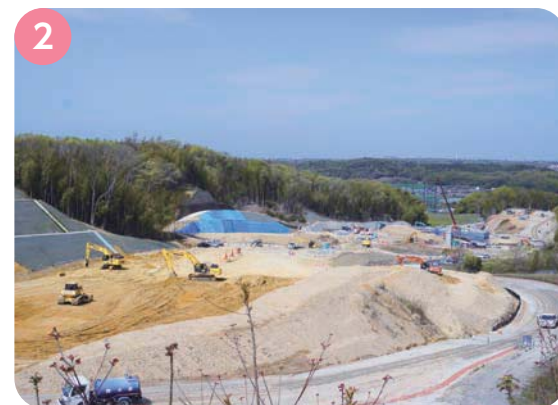
2 櫛谷IC付近 永井谷JCTから県道明石木見線と交差する間において、山を掘削する土工工事を実施しています。
