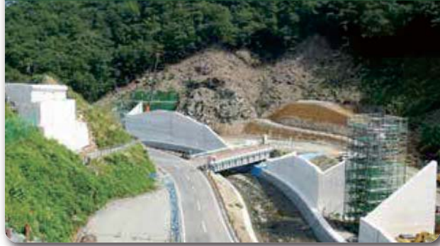
① 播磨新宮IC付近 施工状況
