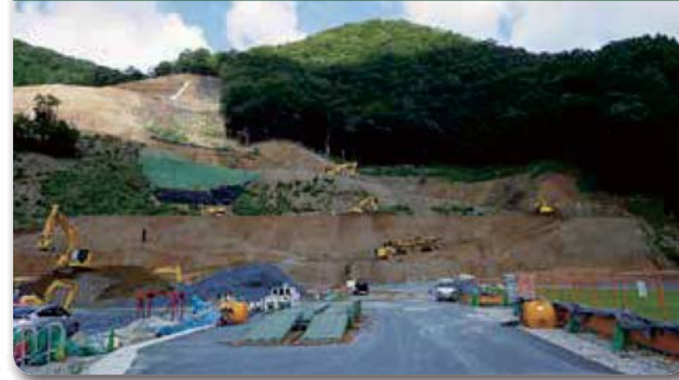
③ 時重地区 施工状況
