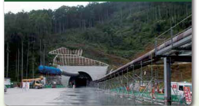
⑧ 国見山トンネル北側坑口 施工状況
