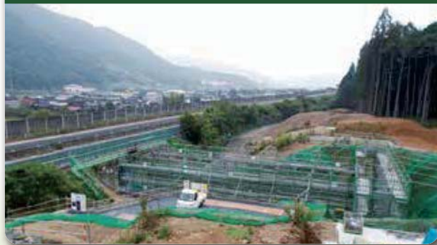
⑥ 山崎JCT C-Box 施工状況
