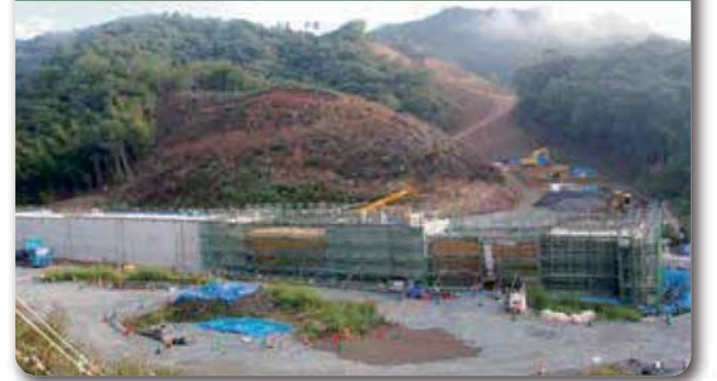
④ 牧地区 施工状況
