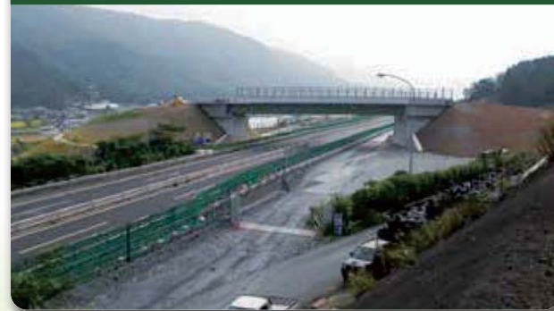
⑦ 山崎JCT ランプ橋 施工状況
