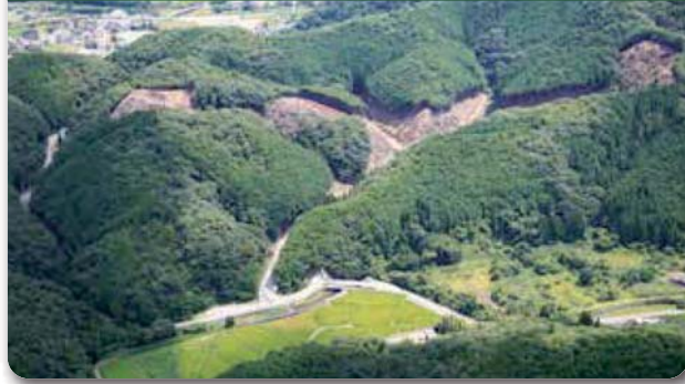
② 筋原地区 施工状況
