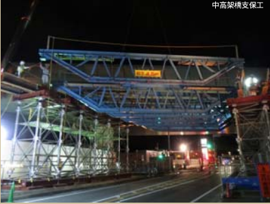
中高架橋支保工
