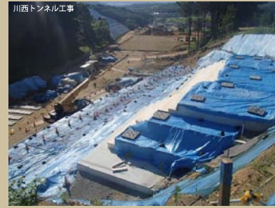
川西トンネル工事
