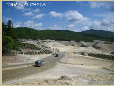
宝塚SA(仮称)建設予定地
