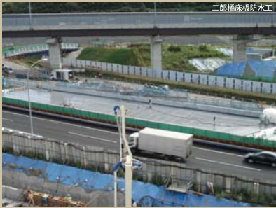
二郎橋床板防水工
