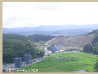
川西インターチェンジ工事
