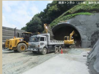
猪瀬トンネル(上り線)掘削状況
