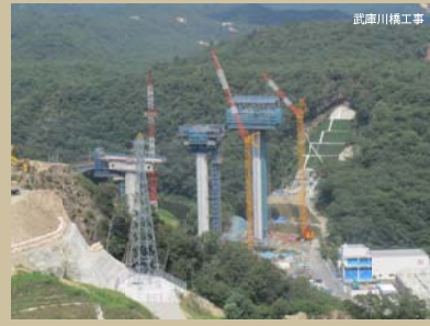
武庫川橋工事
