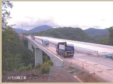
川下川橋工事
