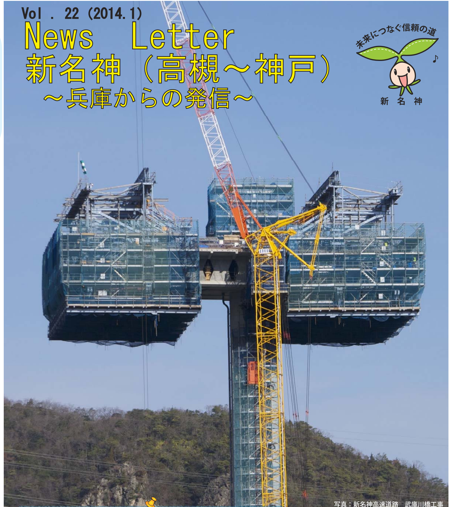
写真：新名神高速道路 武庫川橋工事
