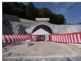
9/12 道場トンネル工事
