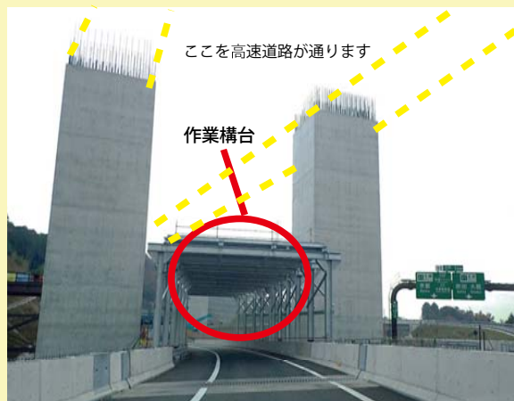
①高槻 JCT で 橋桁架設を行うために工事車両通行用仮橋 および作業構台を設置しました。
