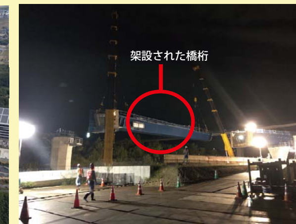
⑥国道1号BPを夜間通行止めし、橋桁を架設しました。
