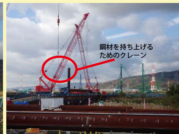
③淀川の河川内で橋脚の基礎となる部分の施工を行っています。
