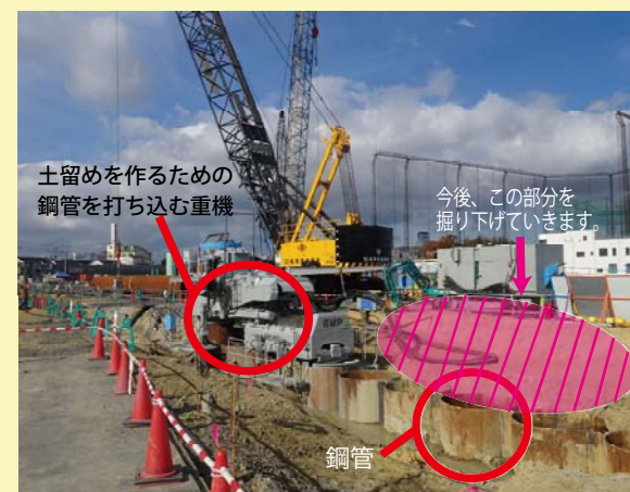
⑤トンネル掘削のための立坑(※2)を施工しています。
