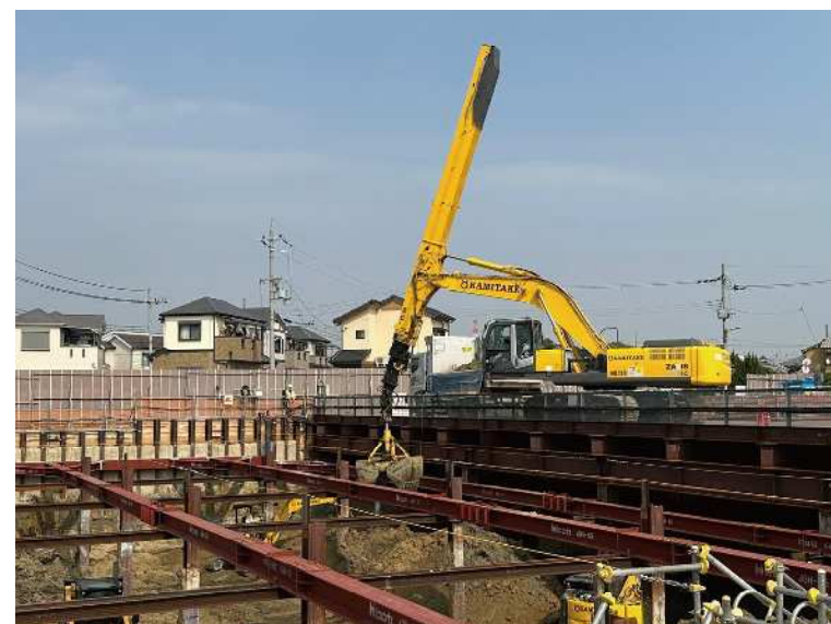
⑥ 掘削区間の施工を行っております。
