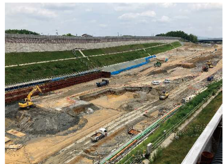
⑧ 掘削区間の施工を行っております。
