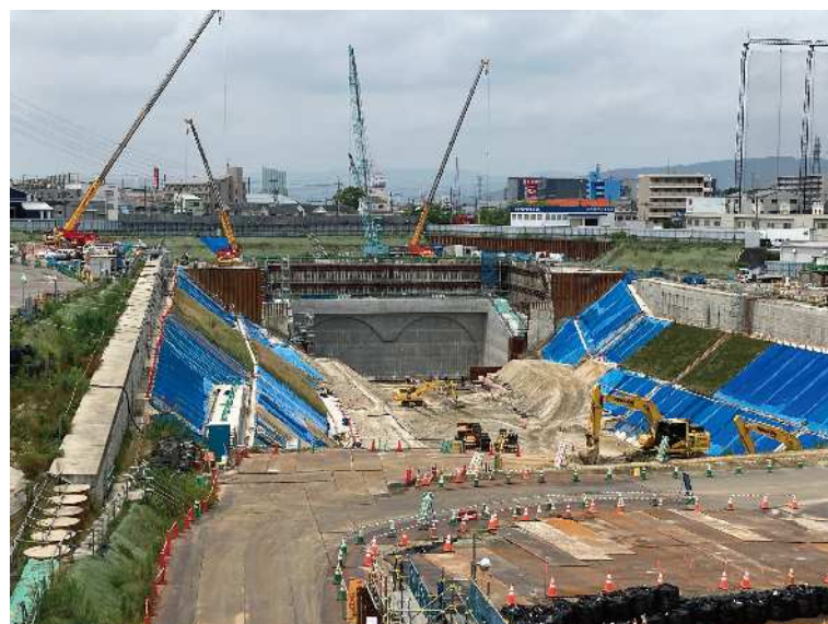
⑦ 掘削区間の施工を行っております。
