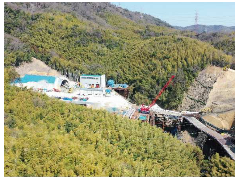
② トンネル・土工部の施工を行っております。
