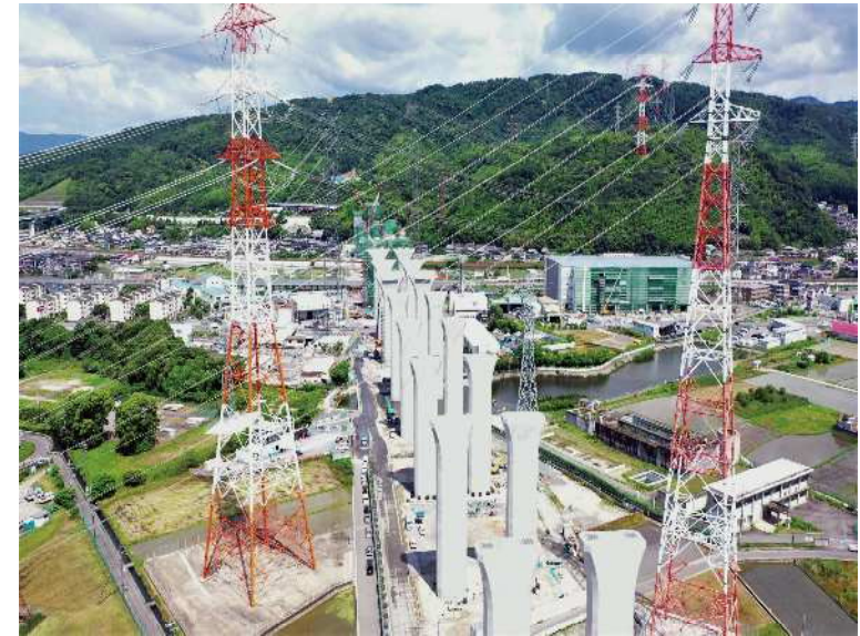
④ 国道 171 号東側の橋脚の施工が完了しました。
