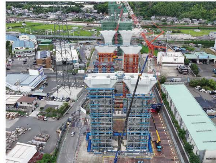
④ 橋梁上部工架設のためのベント（仮受け構台）の施工を行っております。
