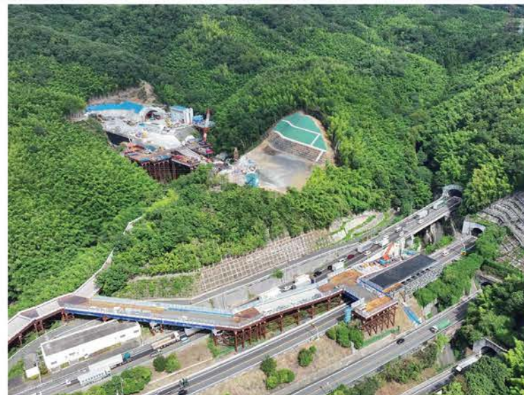
② トンネル・土工部・橋梁下部工の施工を行っております。
