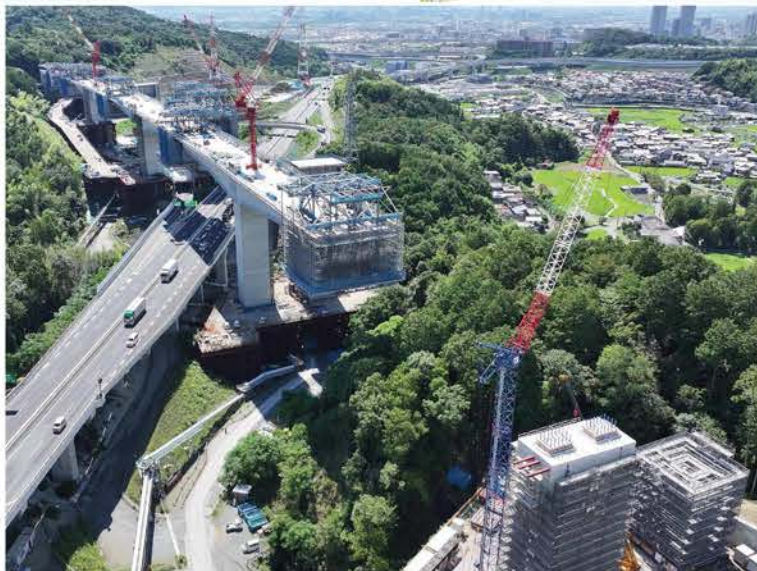
① 橋梁上部工の張出架設及び橋梁下部工の施工を行っております。
