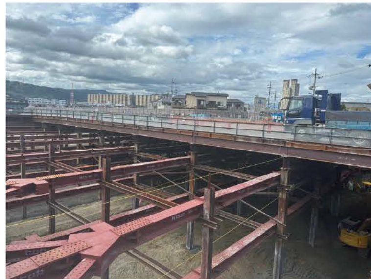
⑥ 掘割区間の施工を行っております。
