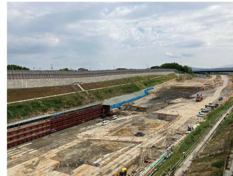
⑧ 掘割区間の施工を行っております。
