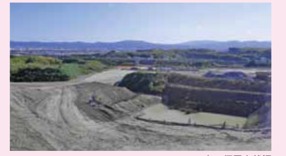
土の仮置き状況
