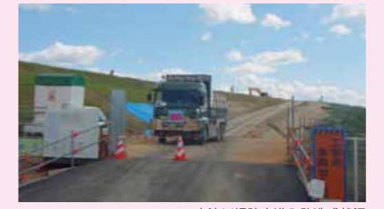
木津川堤防内入路造成状況
