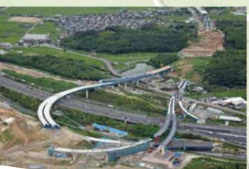
上部工は、コンクリート桁の施工が概ね完了し、国道1号の夜間通行止めをしながら、鋼桁の架設工事を進めています。また、架設完了箇所の床版工事も順次進めています。
