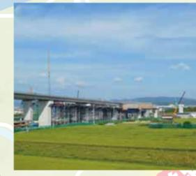
からコンクリート桁の施工を行っており、約5割の架設が完了しています。また、京奈道路との交差点付近では、鋼桁の架設を行っています。
