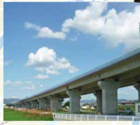
上部工は、西側を大型移動支保工、東側では固定支保工によるコンクリート桁の施工を行っています。約8割の架設を完了し、壁高欄の施工も順次進めています。
