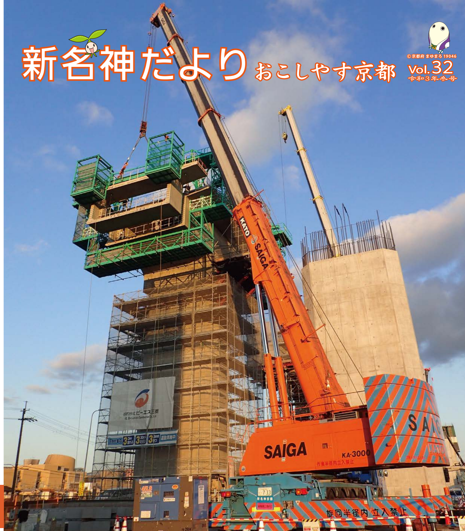
城陽高架橋(仮称)工場製セグメント桁の架設作業
