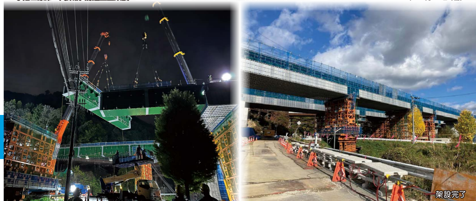
宇治田原第一高架橋 府道上空架設
