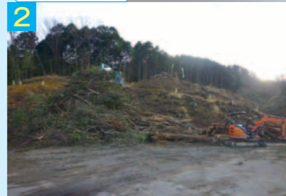
立木伐採作業中
