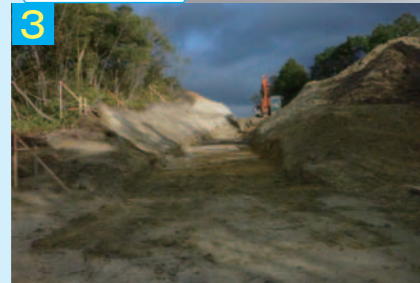
工事用道路施工中
