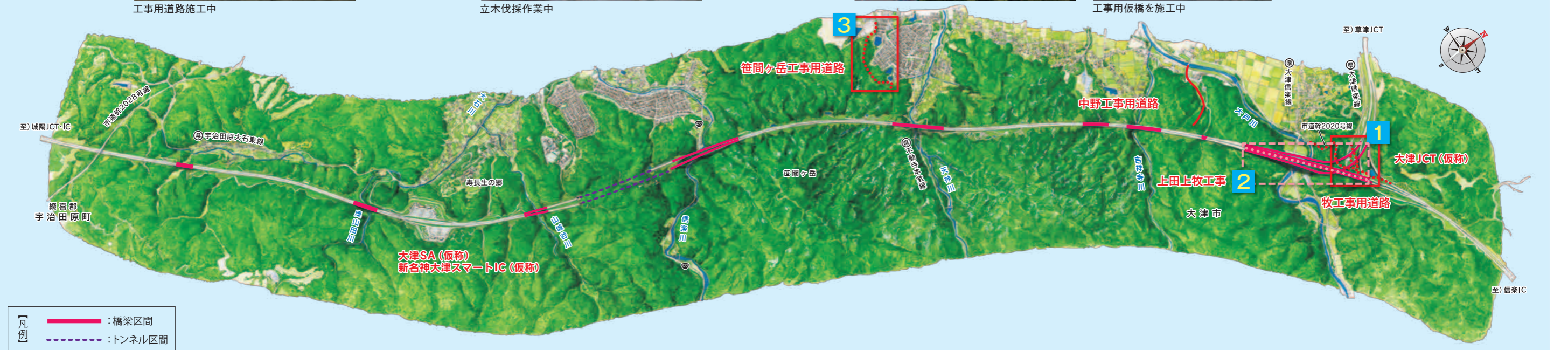
拡幅工事を実施中
