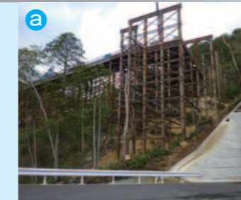
工事用仮橋を施工中
