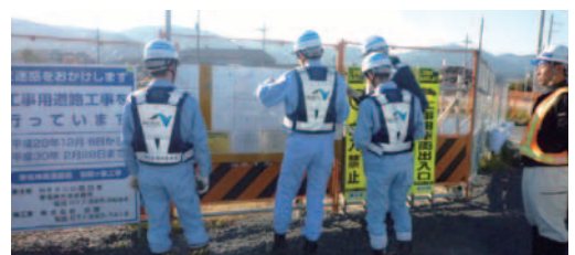
安全パトロールの様子
