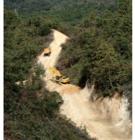
本線部場内道路を施工中
