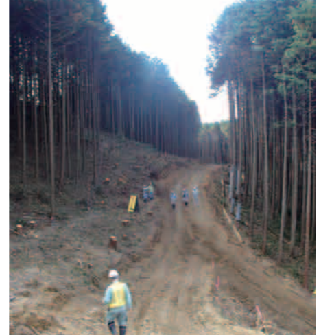
工事用道路伐採状況
