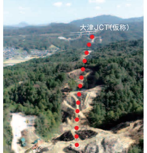
本線部場内道路を施工中
