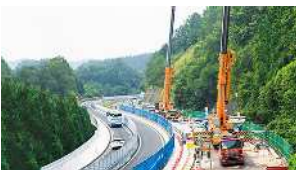
リニューアル工事状況(床版取替)
