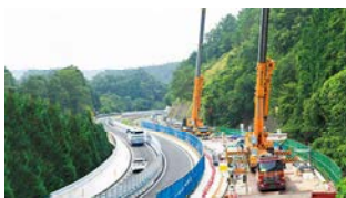
リニューアル工事状況(床版取替)
