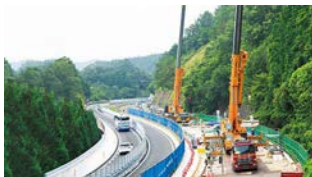
リニューアル工事状況(床版取替)
