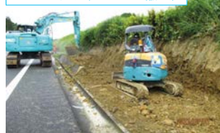
施工中状況(中分盛土撤去)
