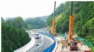
リニューアル工事状況(床版取替)
