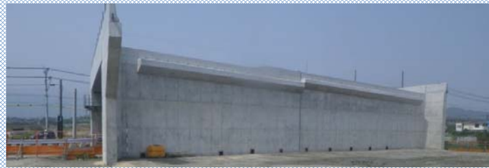
完成した吉国第二橋の側面。この後、土が盛られます
