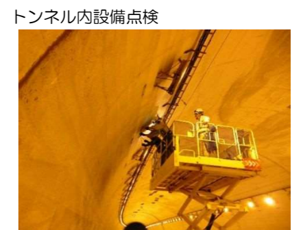
トンネル内設備点検
