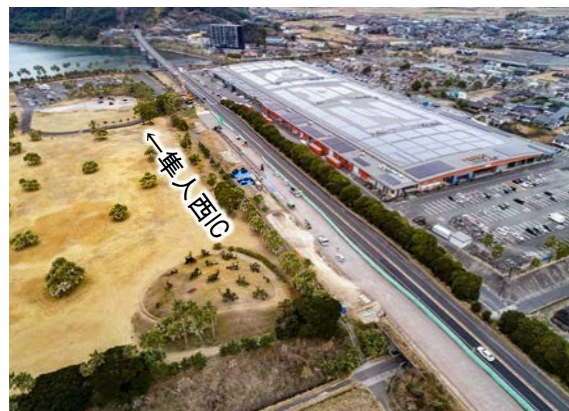
④清水川橋付近
