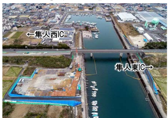
⑤隼人港橋付近
