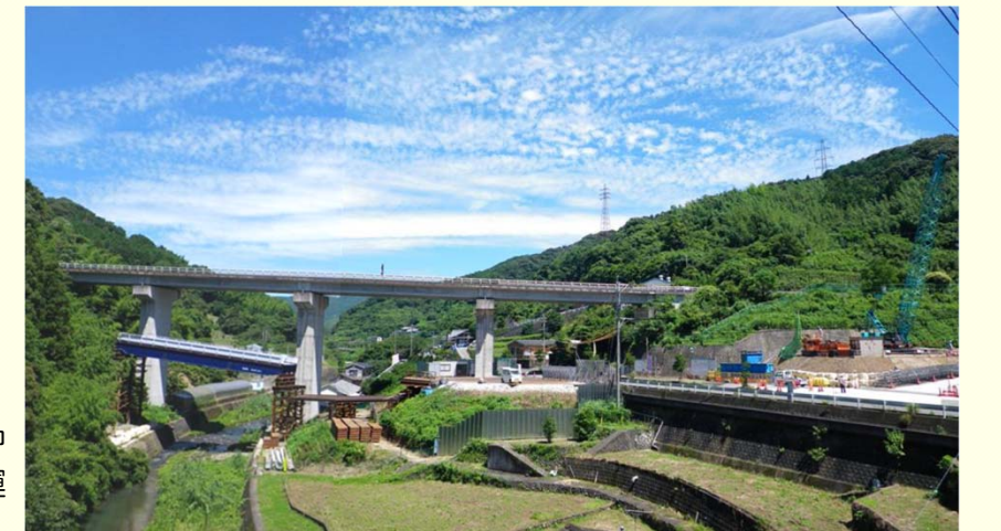
現川橋施工状況(H27.7.9撮影)
