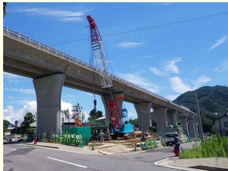
平間橋施工状況(H27.7.9撮影)
