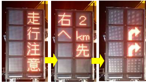
②平間トンネル出口付近
