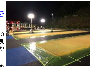
料金所前カラー舗装
