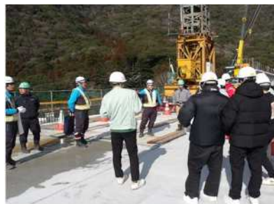
香下大橋(PC上部工)工事
