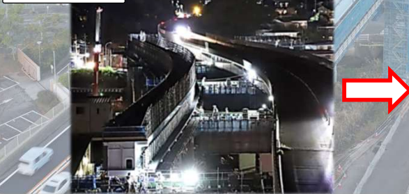
夜間施工状況
