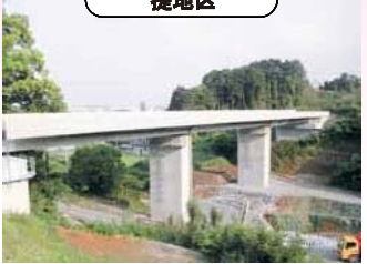
橋梁の施工が完了しました。
