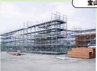
橋梁の施工を行っています。
