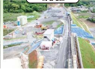
盛土の施工を行っています。
