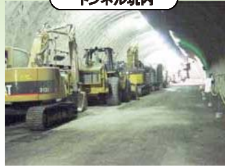
掘削状況6月16日現在 350m
