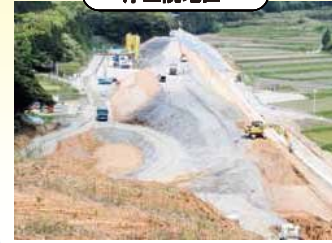
盛土の施工を行っています。
