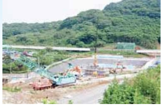
橋梁の施工を行っています。
