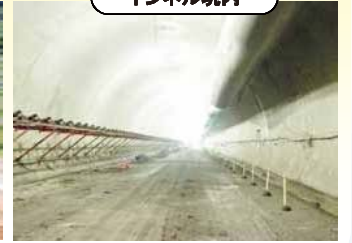
覆工コンクリートの施工を行っています。
