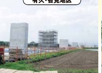
橋梁・カルバートボックスの施工を行っています。
