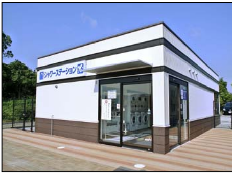
山陽道 淡河PA(上)シャワーステーション
