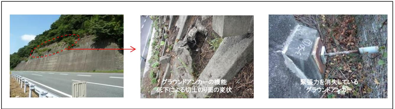
図-4 土構造物（グラウンドアンカー）の主な変状
