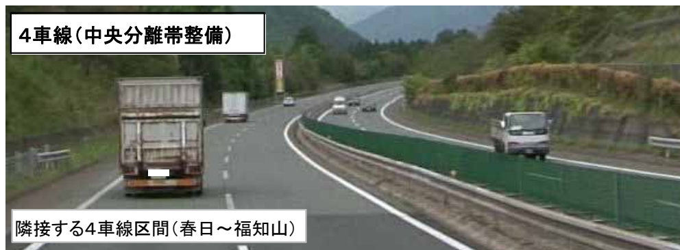
▲2車線区間と4車線区間
