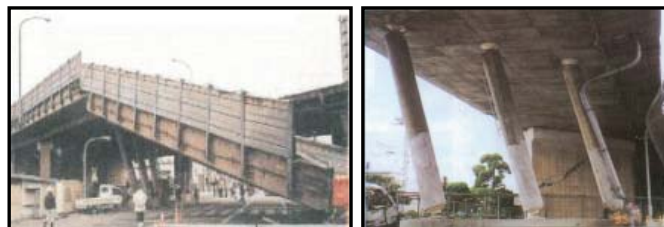
瓦木西高架橋
