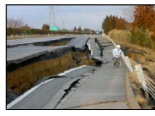
常磐道 水戸～那珂間
