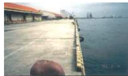
被害が軽微だった耐震岸壁(神戸港)
