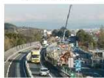
写真1 工事状況(床版取替)
