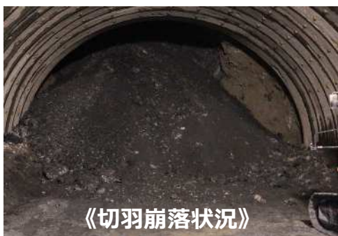
宇治田原トンネル(仮称)の掘削状況
