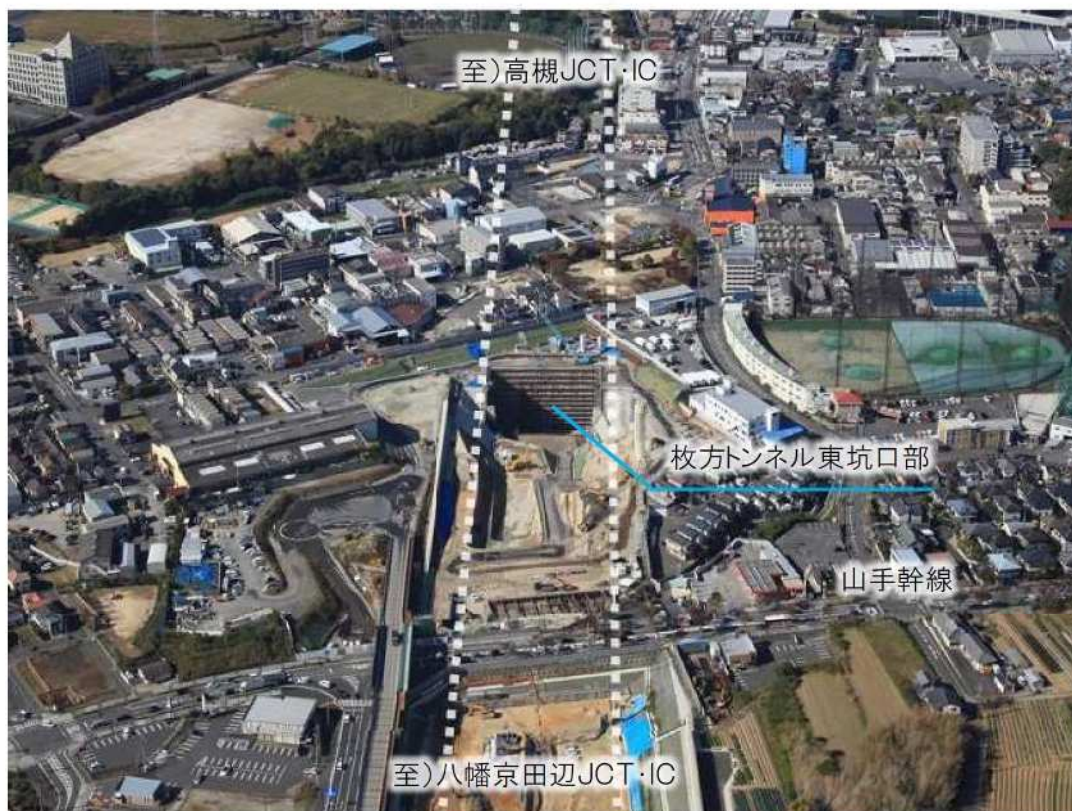
枚方トンネル(仮称)東坑口部付近
