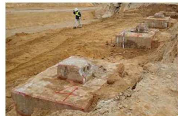
コンクリート構造物等の撤去作業を追加
