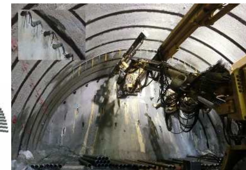
AGF工法(注入式長尺鋼管先受工) ※下図及び写真は他現場事例
