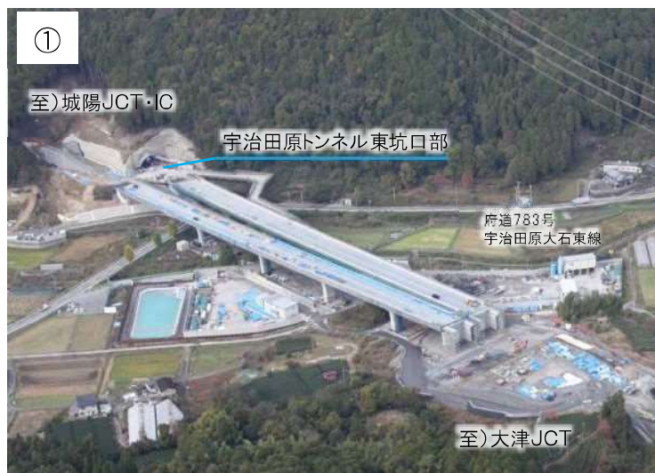
宇治田原トンネル東坑口部付近の整備状況 (2023年11月撮影)
