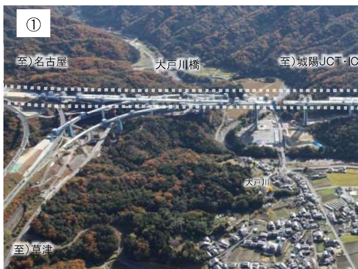
大戸川橋の整備状況 (2023年11月撮影)
