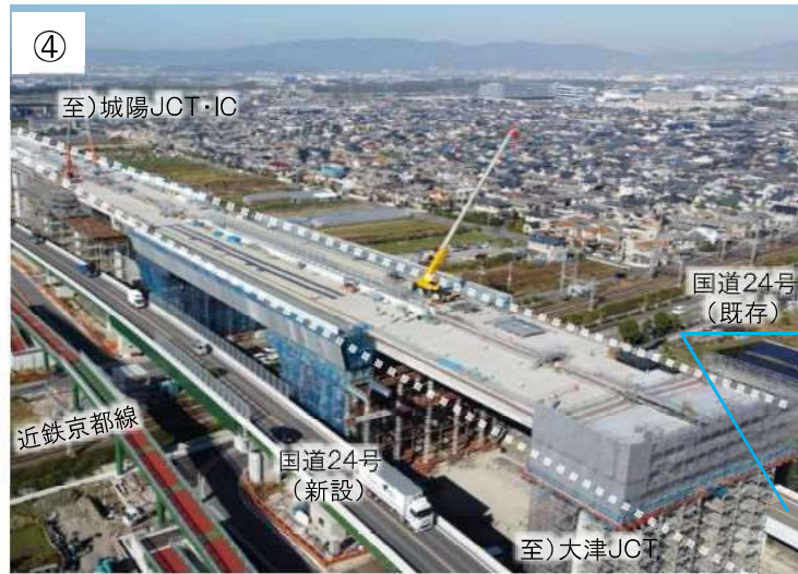
城陽高架橋の整備状況 (2023年11月撮影)
