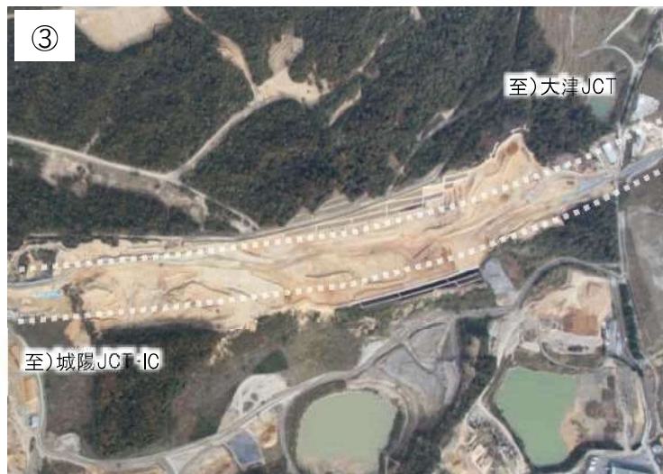
城陽市域土工部の整備状況 (2023年11月撮影)
