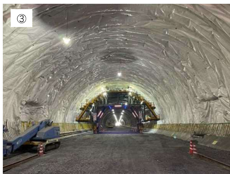
大津大石トンネルの整備状況 (2023年11月撮影)
