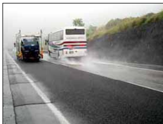
《高機能舗装区間の拡大》
