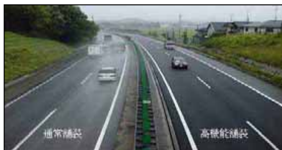
通常舗装と高機能舗装との比較例
