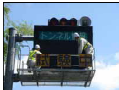
《情報板の点検》
