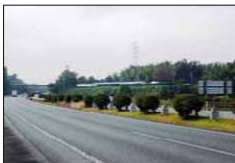
《中分防護柵（整備前）》
