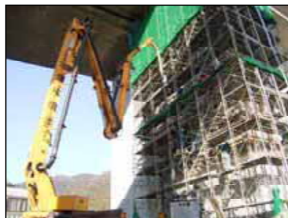
《橋脚耐震補強工事の状況》
