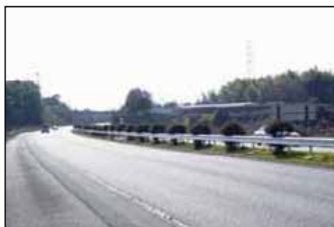
《強化型中分防護柵（整備後）》
