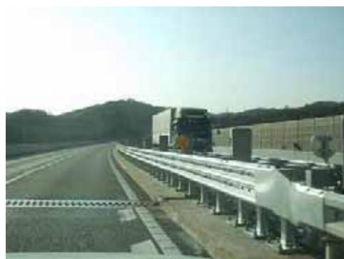
山陽道和歌山IC 80 (整備後)
