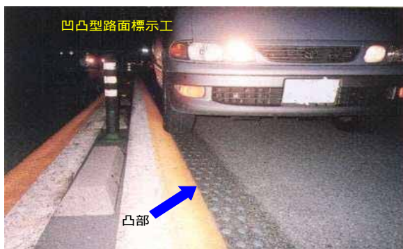
路面の凹凸により反対車線への逸脱を防止します
