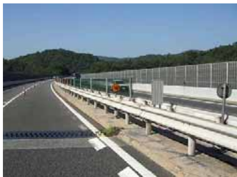
山陽道和歌山IC 80 (整備前)
