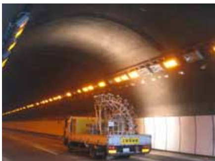
トンネル覆工撮影状況
