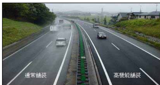
通常舗装と高機能舗装との比較例
