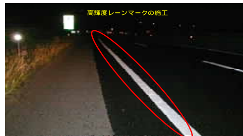
高輝度レーンマークの施工例
