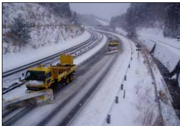
高速道路における除雪作業状況
