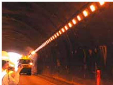
トンネル照明器具の清掃状況
