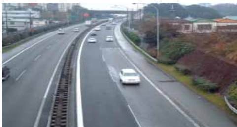
高機能舗装の施工例
