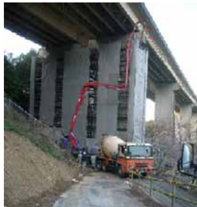
長崎道、井樋ノ尾川橋
