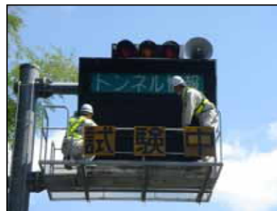
情報板の点検
