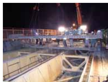
PC床版を用いた床版取替え
