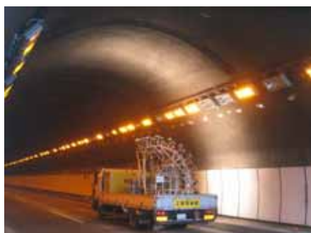
トンネル覆工撮影状況
