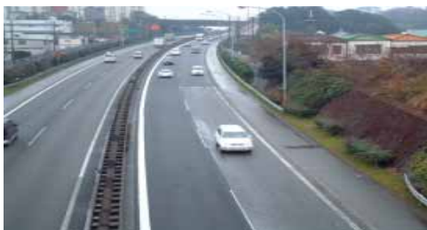
高機能舗装の整備例
