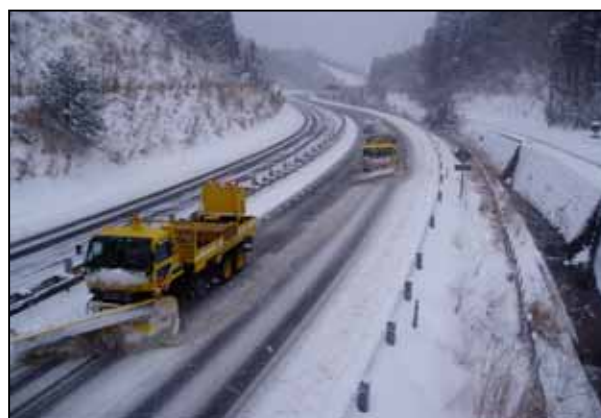
高速道路における除雪作業状況
