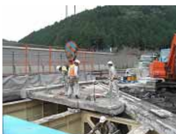
既設床版の撤去
