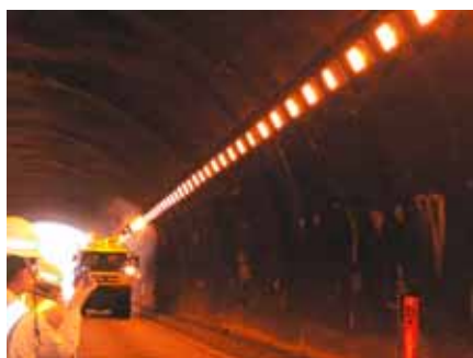
トンネル照明器具の清掃状況
