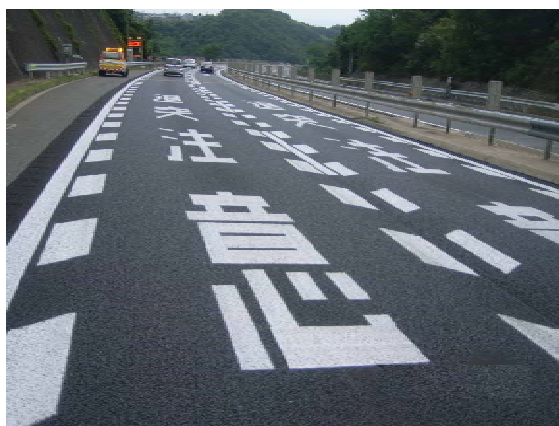
導流レーンマーク：京都縦貫道、キロポスト12付近
