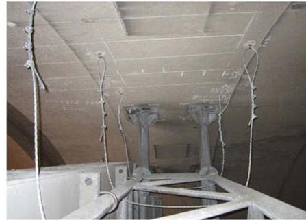
応急対応：フェールセーフワイヤー設置状況
