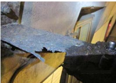
標識灯取付部の腐食による欠損
