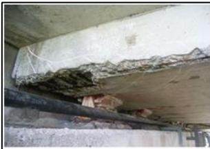
コンクリートの剥離、鉄筋腐食
