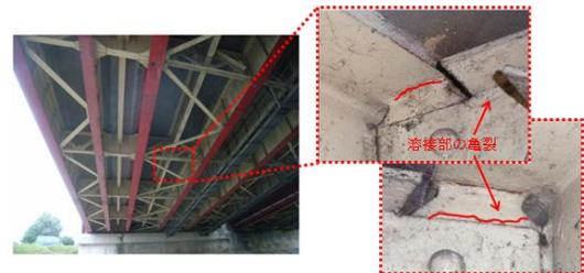
対傾構と垂直補剛材取付ガセット部の亀裂
