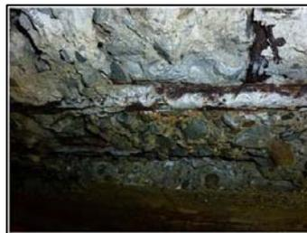
コンクリートの剥離、鉄筋腐食
