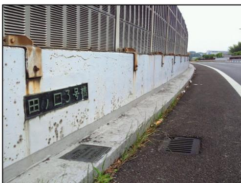
《壁高欄の損傷(補修前)》
