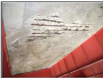
コンクリートの剥離、鉄筋腐食
