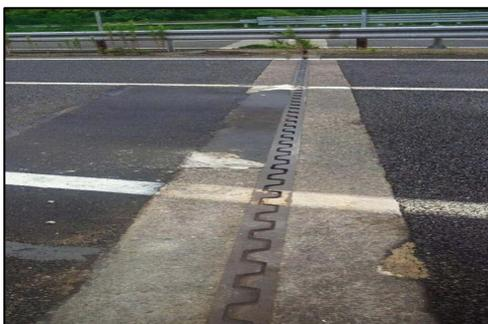
《伸縮装置の損傷(補修前)》
