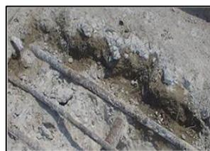
コンクリートの土砂化
