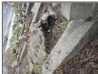
グラウンドアンカーの機能低下による切土のり面の変状
