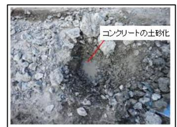
コンクリートの土砂化
