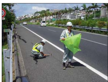
《路面の点検状況》
