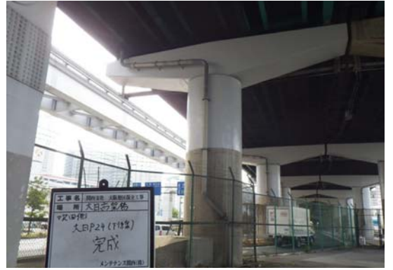
《橋梁下部工はく落対策(補修後)》
