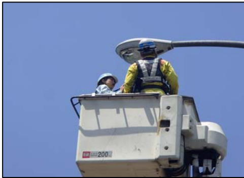
《道路照明の点検状況》
