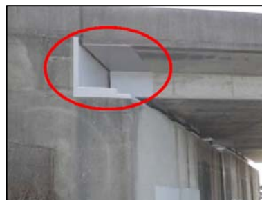
《桁端部の補修》
