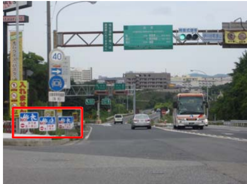
《注意喚起看板による立入防止対策》
