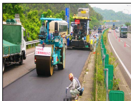
《終日車線規制等における舗装補修状況》
