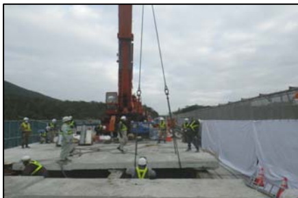
《床版取替状況》
