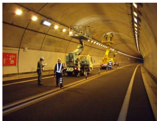
《トンネル覆工の点検状況》
