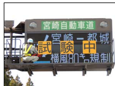
《情報板の点検状況》
