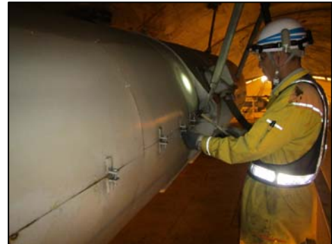
《トンネル換気設備の点検状況》
