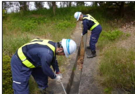
《不動産管理点検時の排水溝清掃》
