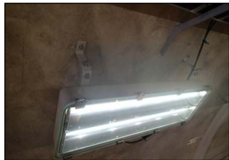
《トンネル照明の緊急補修(補修後)》
