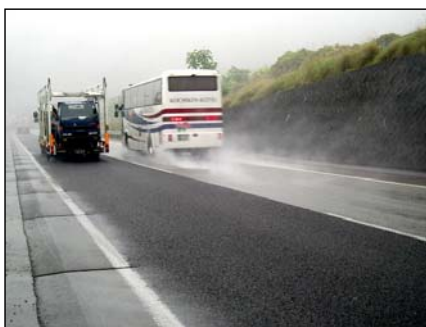
「高機能舗装施工前後の路面状況」 左車線：高機能舗装・右車線：従来舗装
