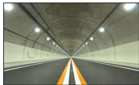
《更新後のLED照明》
