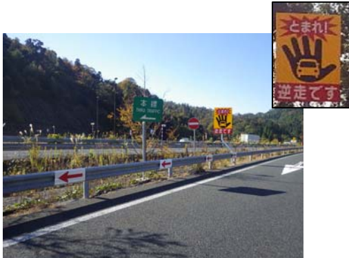
《SA・PA: 矢印路面標示+注意喚起標識》
