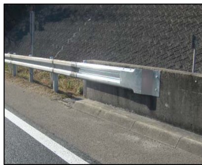
《ガードレール連続化の整備》
