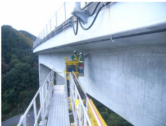
《橋梁下面の点検状況》
