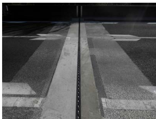
《伸縮装置の損傷(補修後)》
