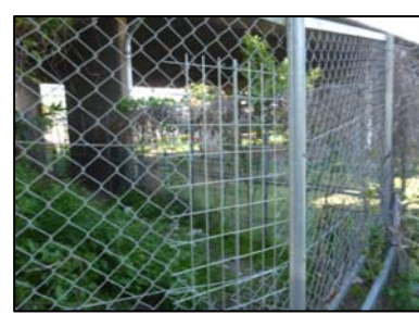
《立ち入り防止柵の補修》
