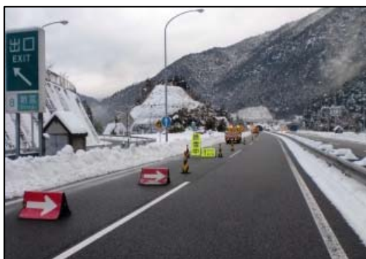
《走行車線規制による通行止め解除(SS作戦)》
