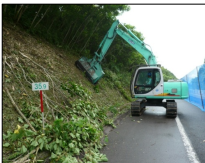
《全面草刈の機械化による省力化》
