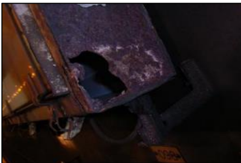
《トンネル照明の緊急補修(補修前)》
