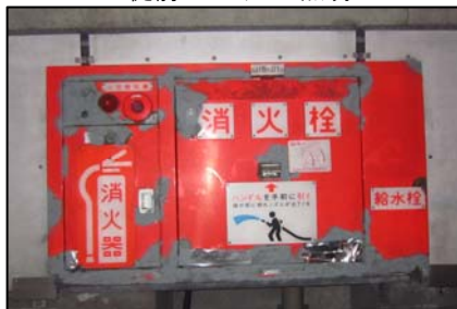
《従前の消火栓》
