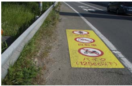
《路面標示による立入防止対策》
