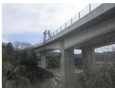
《橋梁の点検状況》
