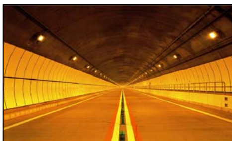
《従前のナトリウム照明》
