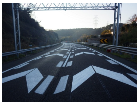
《高機能舗装及び導流レーンマークの実施》
