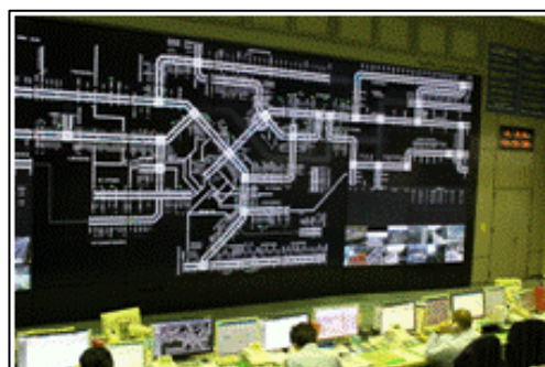
《 道路管制センター 》
