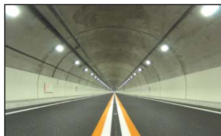
《更新後のLED照明》
