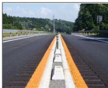
《凹凸レーンマークによる対策》
