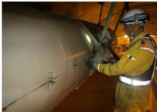
《トンネル換気設備の点検状況》
