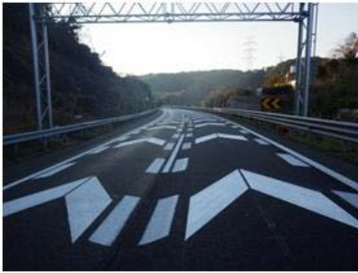
《高機能舗装及び導流レーンマーク》
