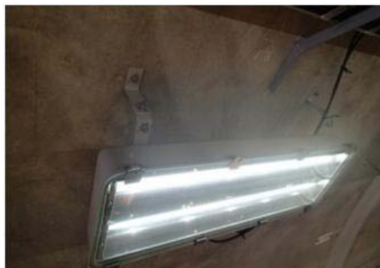
《トンネル照明の緊急補修(補修後)》
