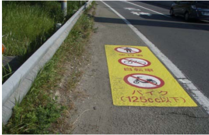
《路面標示による立入防止対策》
