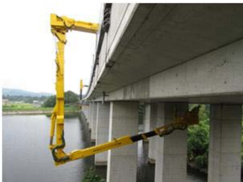
《橋梁下面の点検状況》
