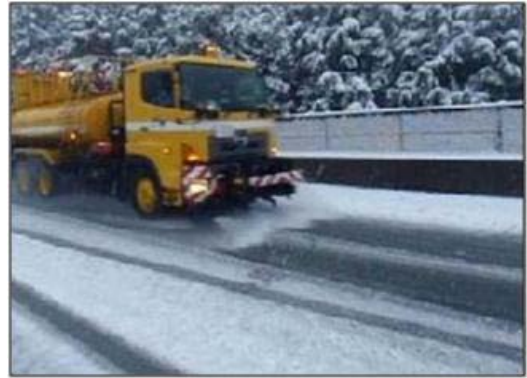
《散水車による雪氷対策作業》
