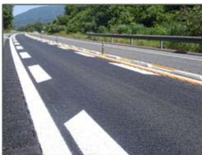
《導流レーンマークによる対策》
