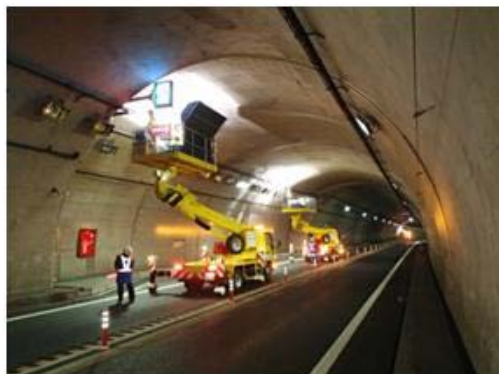
《トンネル覆工の点検状況》
