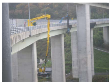
《路面の点検状況》
