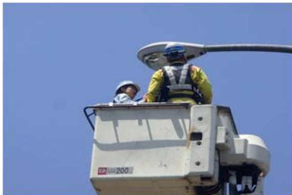
《道路照明の点検状況》
