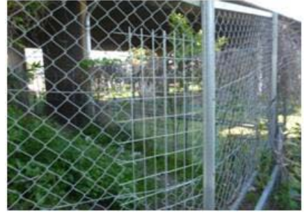
《立入防止柵の補修》
