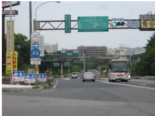
《注意喚起看板による立入防止対策》
