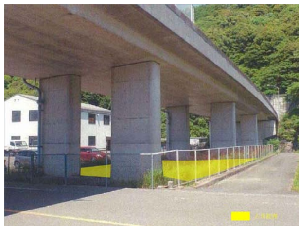
≪ 占用入札箇所(松山道 井内川橋高架下) ≫
