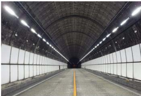
《トンネル照明のLED化》
