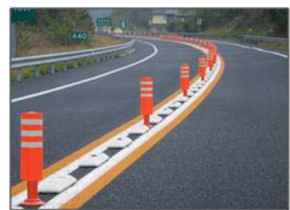
《ラバーポール改良による対策》
