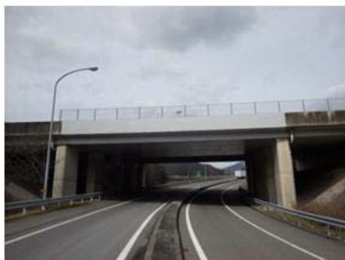
《橋梁上部工はく落対策(補修後)》
