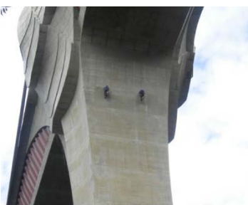
《橋梁の点検状況》
