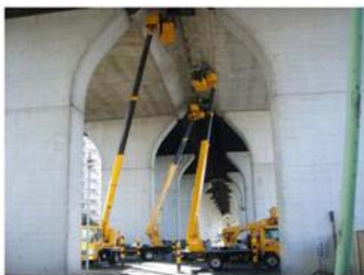
《コンクリート片剥落対策(橋梁)》
