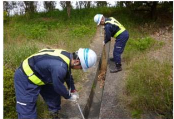
《不動産管理点検時の排水溝清掃》
