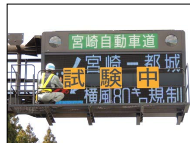
《情報板の点検状況》
