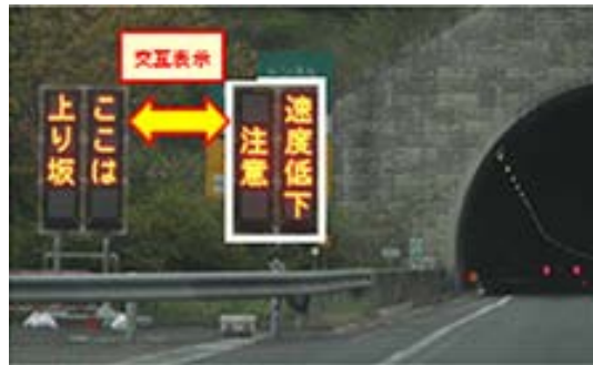
《LED標識による速度低下の注意喚起》
