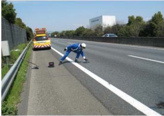
《交通パトロール時の簡易な舗装補修》
