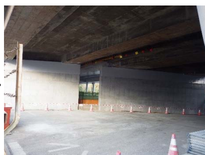
《ロックンク橋脚補強後》
