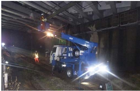
《橋梁下面の点検状況(鉄道交差)》
