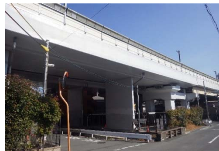
《橋梁上部工はく落対策(補修後)》
