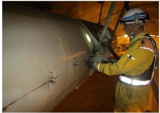
《トンネル換気設備の点検状況》
