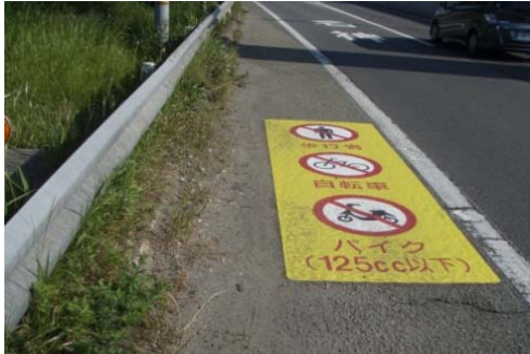
《路面標示による立入防止対策》
