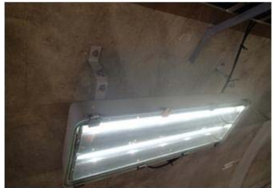
《トンネル照明の緊急補修(補修後)》
