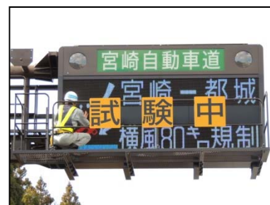
《情報板の点検状況》
