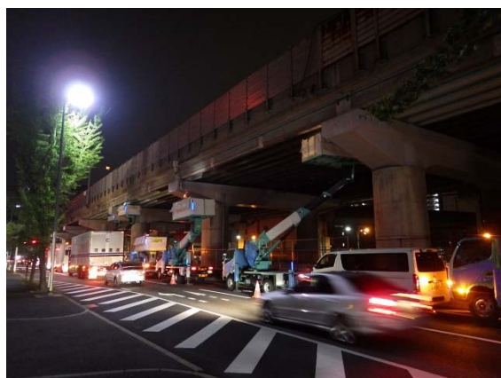
《コンクリート片剥落対策(橋梁)》
