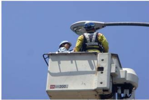
《道路照明の点検状況》
