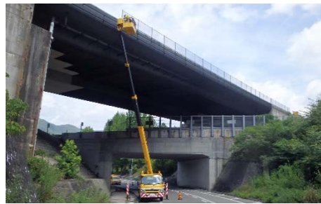
《橋梁下面の点検状況》
