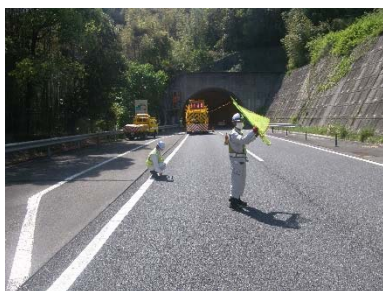
《路面の点検状況》
