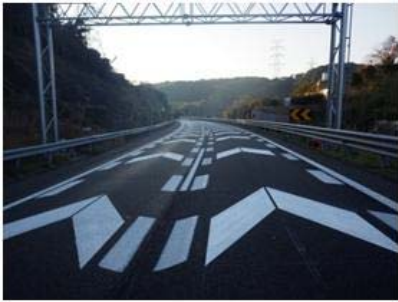
《高機能舗装及び導流レーンマーク》
