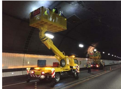
《トンネル覆工の点検状況》
