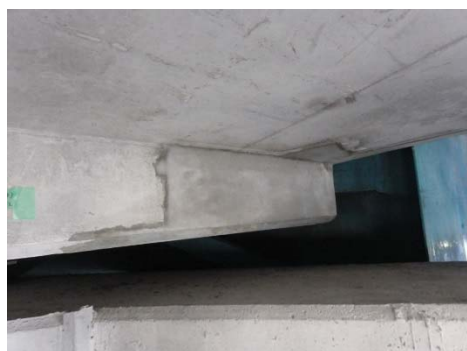
《橋梁桁端部補修(橋梁)》
