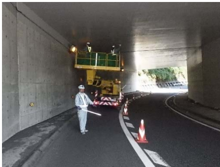
《ボックスカルバートの点検状況》
