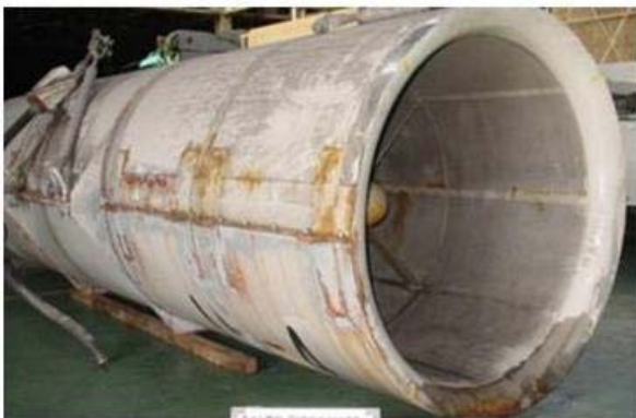
《トンネルジェットファン(補修前)》
