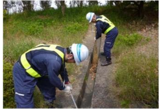
《不動産管理点検時の排水溝清掃》
