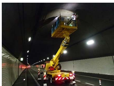
《トンネルの点検状況》
