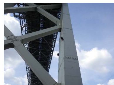
《橋梁の点検状況》
