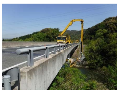
《橋梁の点検状況》
