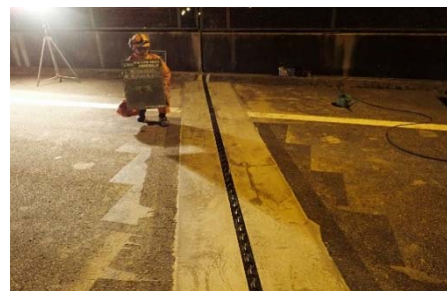
《伸縮装置の損傷(補修後)》
