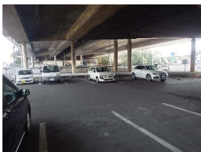
《ロックンク橋脚補強前》
