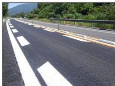
《導流レーンマークによる対策》
