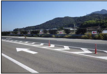
《ラバーポール＋大型矢印路面標示》
