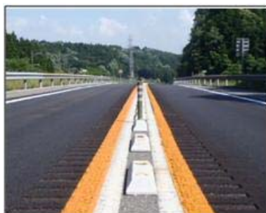
《凹凸レーンマークによる対策》
