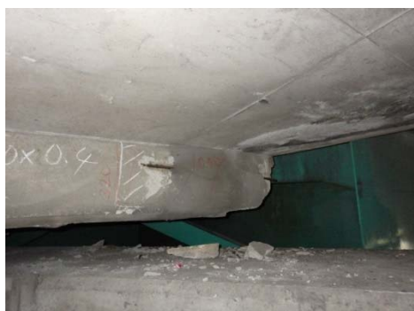
《コンクリート片剥落対策(橋梁)》
