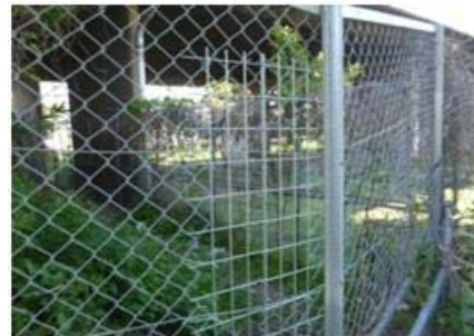
《立入防止柵の補修》
