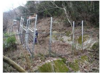
《動物侵入防止対策》
