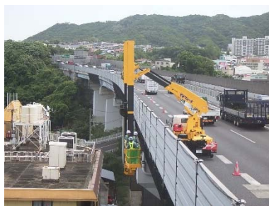
《遮音壁の点検状況》
