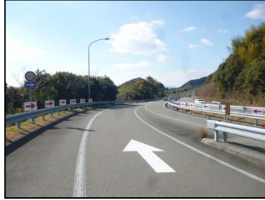
《オフランプ合流部に矢印路面標示》
