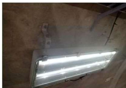
《トンネル照明の緊急補修（補修後）》
