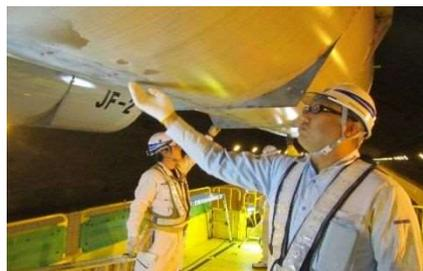
《トンネル換気設備の点検状況》
