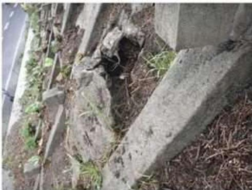
《グラウンドアンカーの機能低下によるのり面変状》
