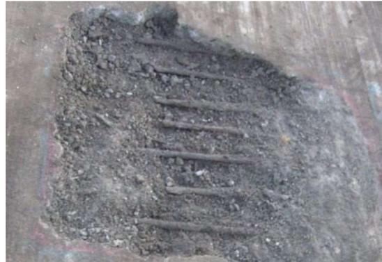
《床版上面のコンクリート土砂化》
