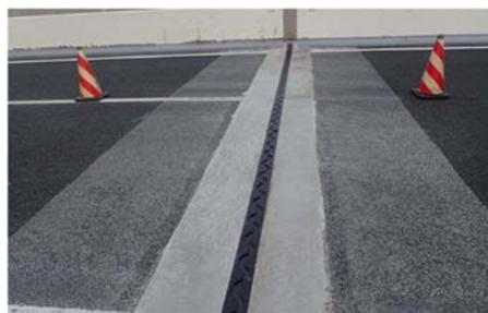
《伸縮装置の損傷（補修後）》
