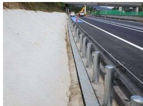
《埋設ケーブルのトラフ化》
