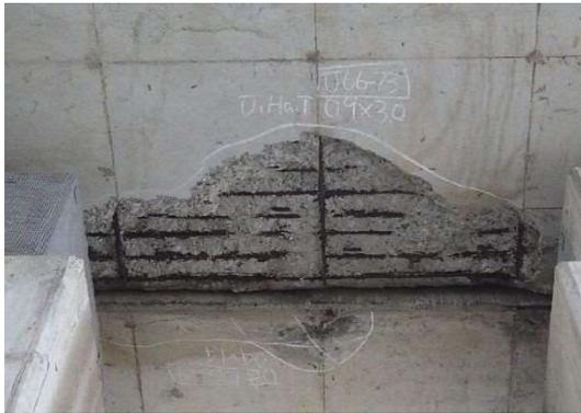
《床版下面のコンクリート剥離・鉄筋腐食》
