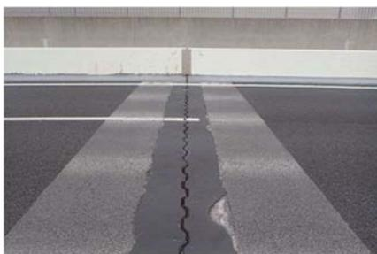
《伸縮装置の損傷（補修前）》
